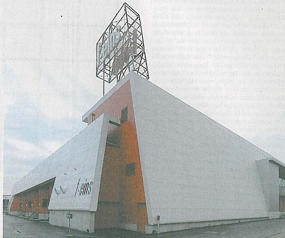
Ein Zweckbau mit kompliziertem Innenleben: Im Süden Wiens wurde Ende 2007 der rund 12.400 m 2 BGF bietende Fleischgroßmarkt f-eins in Betrieb genommen. Bild: Werte Consulting
